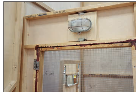
Detail einer Wand
