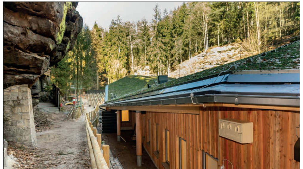
Verschalung des Gebäudes mit Lärchenholz aus dem Tharandter Wald
